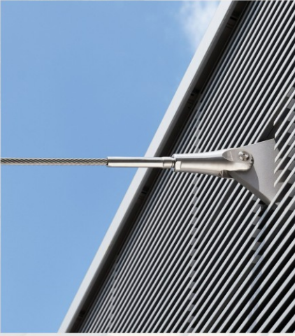
建筑工程 Construction project
