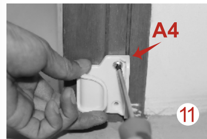
A4をネジで表面に固定します。
